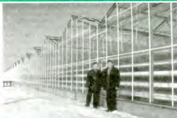
Теплица площадью 1,5 га в ОГУП «Волга» г. Балаково Саратовской области. Реконструкция проведена ООО «Теплицэnergострой»
