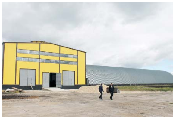
Строительство первой очереди логистического центра в ЗАО «Башмаковский хлеб»
