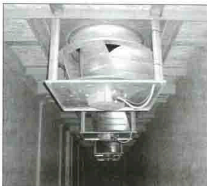
Рис. 4. Энергосберегающие вентиляторы с регулируемым числом оборотов (производство фирмы EBM-PAPST), вмонтированные в магистральный канал
