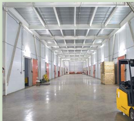
Овощехранилище в Рыбновском районе Рязанской области Фото: http://intss.ru/photo/3.html
