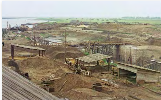
Работы по постройке шлюза на левом берегу Оки выше села Белоомут. 1912 год. Фото: С.М. Прокудин-Горский ( http://prokudin-gorskiy.ru )
