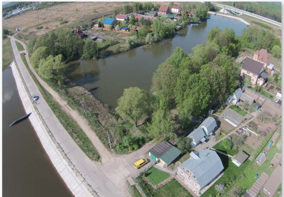
Рис. 1. Вид речного гидроузла с грунтовой плотинной и закрытым сифонным водосбросом (снимок с воздуха квадрокоптером). Фото предоставлено ФГБУ «Управление «Спецмелиоводхоз»
