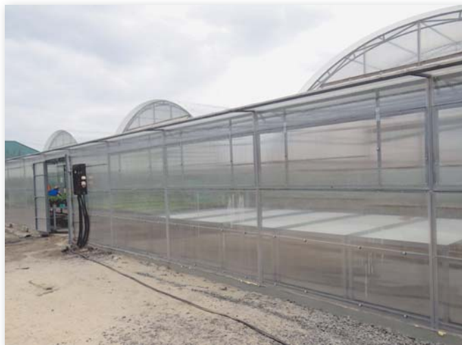
Тамбур при входе в теплицу
